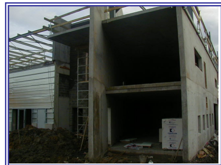
Façade Extérieure Détails
