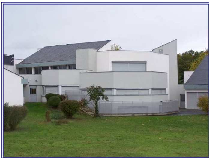
↑ Vue extérieure du CDI (RdC) et accès pôle EPS (sous sol)
