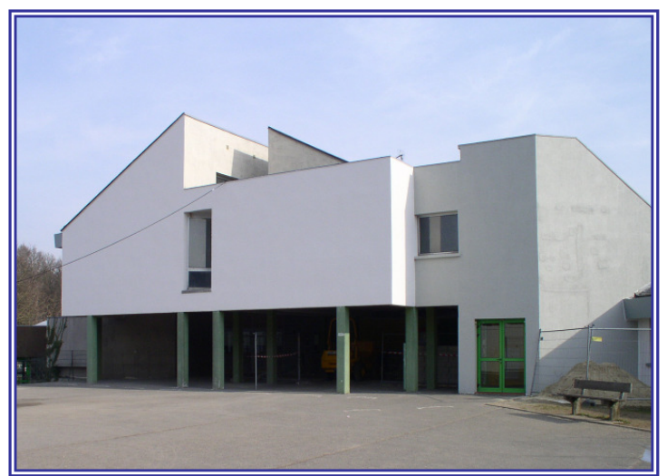
↑ Préau et Enseignement (1 er étage)
