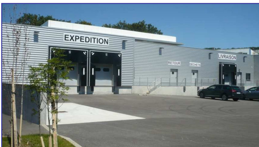
Façade cour de service
