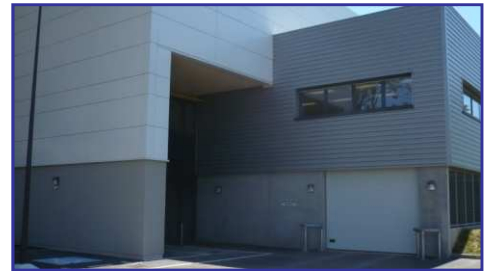
Accès parking couvert
