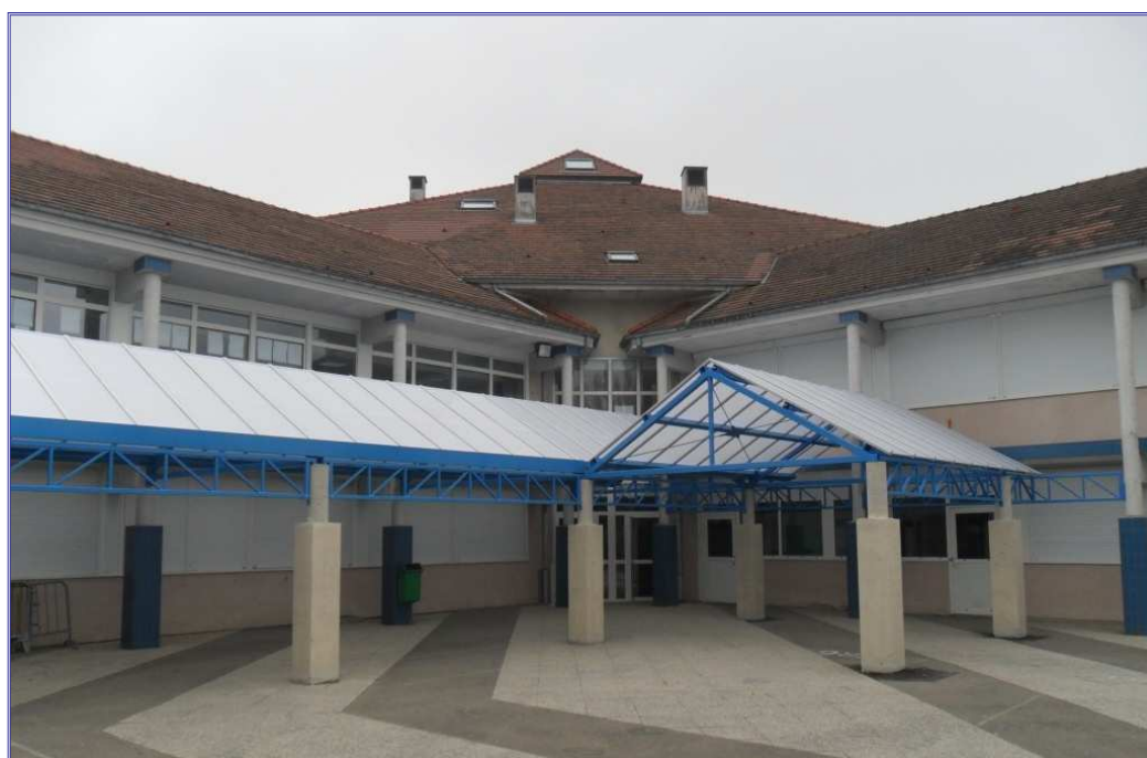
Construction d'un préau
