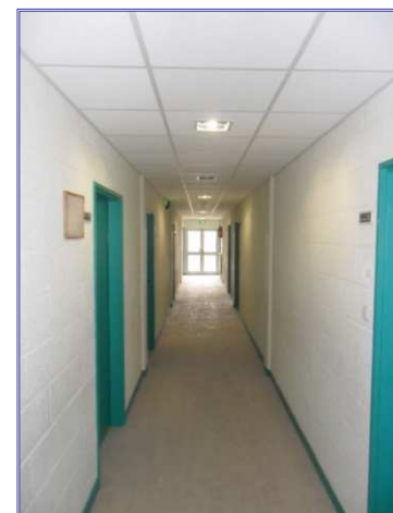
Réalisation des faux-plafonds
