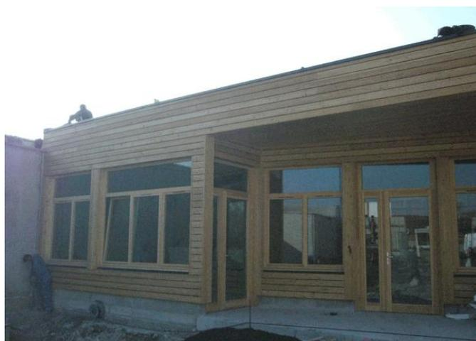
Ce bâtiment est constitué d'une ossature bois, d'une dalle béton, les parements verticaux sont composés de bardage et bardeaux de bois, toiture membrane PVC.
